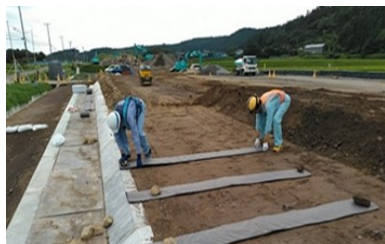
排水材設置工（水平排水層）
