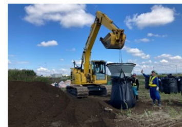
大型土のう工
