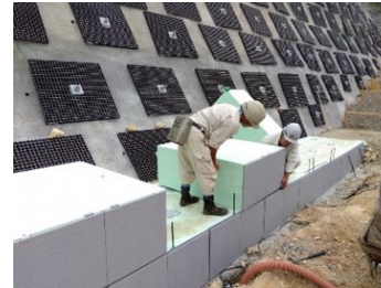
発泡スチロールを用いた超軽量盛土工
