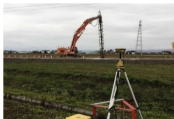
中層混合処理工（ICT）
