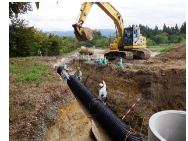
排水構造物工（暗渠排水管）
