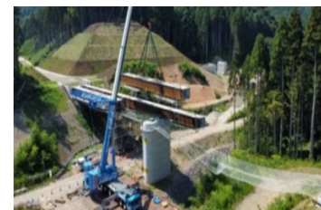
鋼橋架設工
